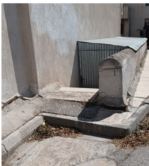
Εικόνα 10 Ρηγμάτωση τοιχίου (Κτίριο Ε)
