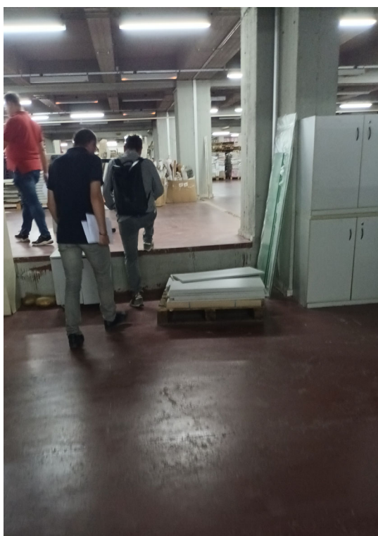
Εικόνα 3 Ανισοσταθμία δαπέδου (ΥΠΟΓΕΙΟ ΔΕΖ)
